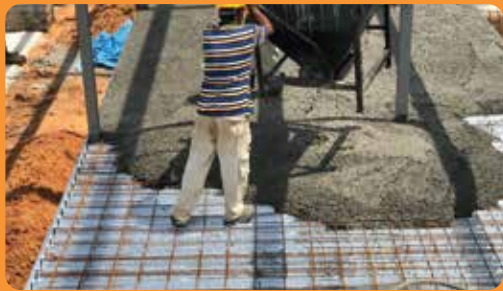
Concrete mixture pour
